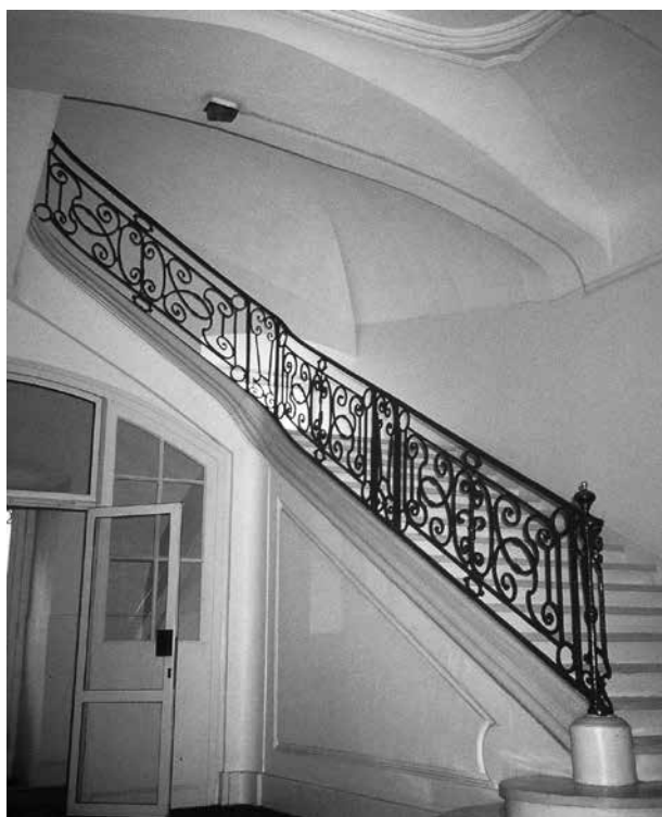
Fig. 6.- La rampe en fer forgé de l'escalier est probablement due à André Portier, architecte qui a travaillé avec Jean Laclotte sur le séminaire des Lazaristes.
