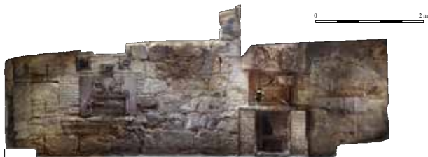
Fig. 22. - Orthophotographie des ouvertures des fours du XIXe siècle.
