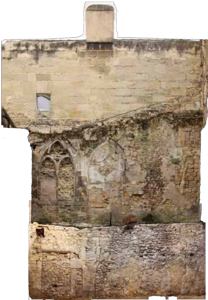
Fig. 10. - Orthophotographie de l'élévation sud.
