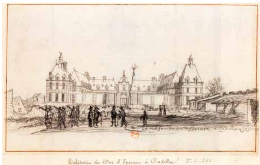
Fig. 9. - La maison du duc d'Épernon à Cadillac par Hermann Van der Hem. 1639. Dessin. © BNF, EST RESERVE VE-26 (N)
